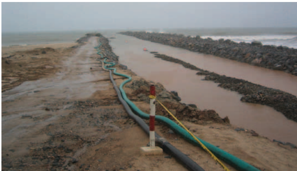
Nigeria: Gasoducto de África Occidental—Talud de protección del gasoducto a su llegada a la costa de Takoradi en Ghana
